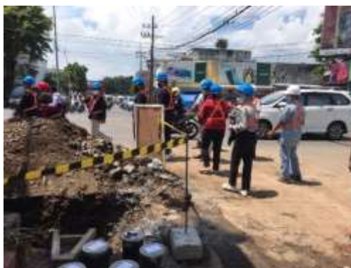
Gambar 1. Komisi C DPRD Kota Malang mengecek saluran air Sumber: Dokumentasi Penelitian Tahun 2021
